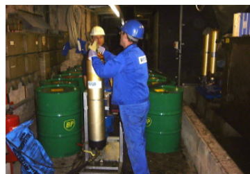
Spülung des Schmieröl- und Reglerölkreises einer Turbine
